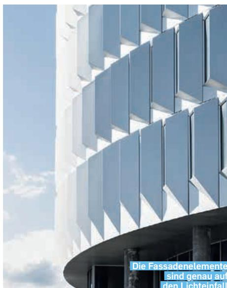
Die Fassadenelemente sind genau auf den Lichteinfall und den Standort abgestimmt.
